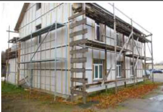
Uz zemes gabala ar kadastra apzīmējumu 6415 003 0142 atrodošā būve
